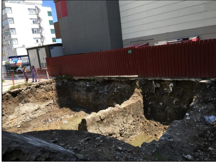
Şekil 50. Yalı Cami avlusunda yapılan kazı sonrasında bulunan kalıntılar
